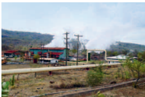
GEOTHERMIEANLAGE IN SAN JACINTO Acht Entwicklungsbanken, darunter mehrere EDFI-Mitglieder, sind an dem Projekt in Nicaragua beteiligt.
